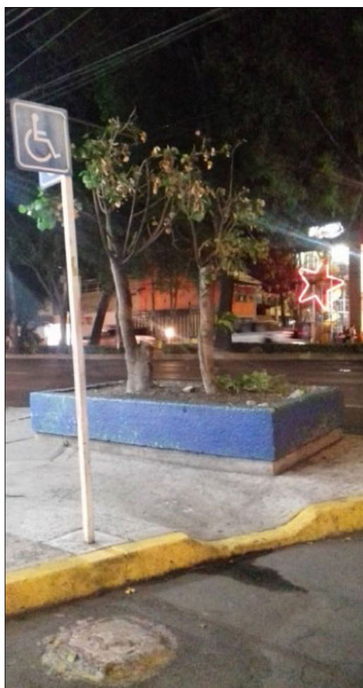
Imagen 3. Avenida Miguel Ángel de Quevedo, Ciudad de México. En la imagen se muestra una esquina en la cual hay una rampa de acceso a la acera que es angosta y además posee un borde ancho entre la superficie de la misma y la de la calle, lo que dificulta su uso. Autora: Laura Paniagua Arguedas, 2018.
