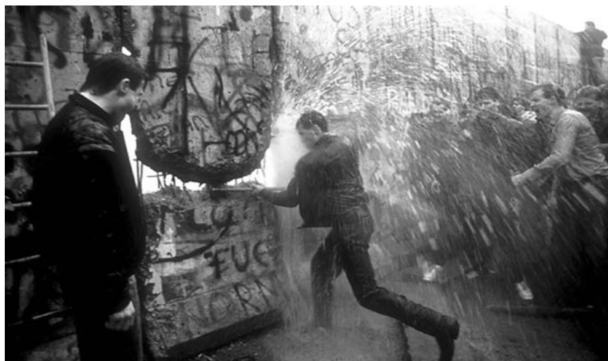
La caída del muro
