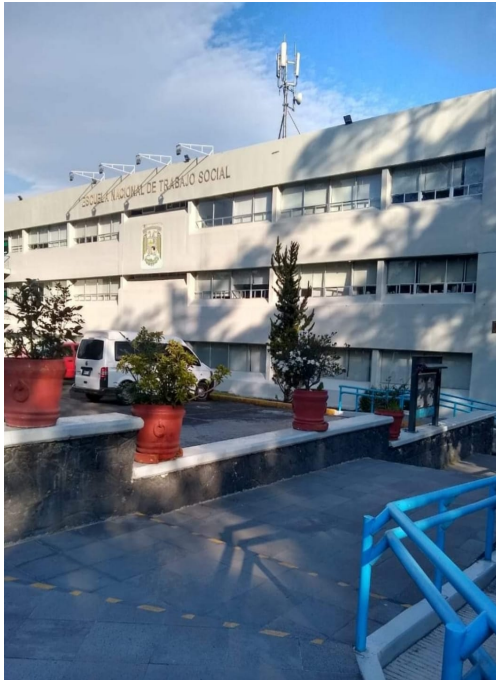
Filtro de seguridad sanitaria 1 Entrada principal
